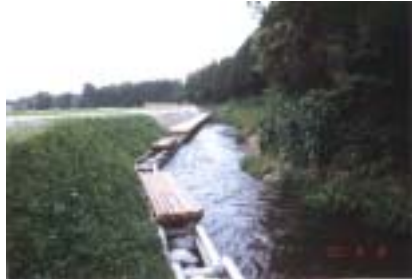
環境に配慮した水路
