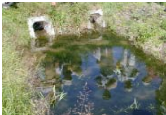
排水路と水田間の魚類移動障害解消実証施設（暗渠工、ボックス、管により比較）
