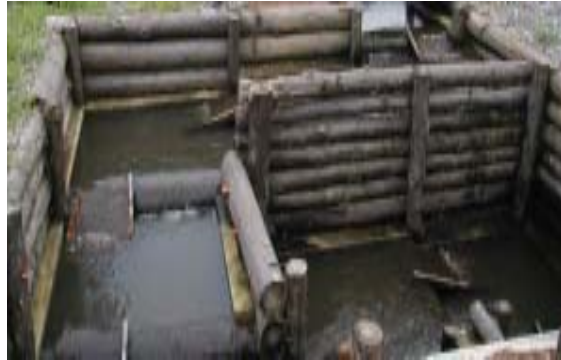
排水路と水田間の魚類移動障害解消実証施設（越流壁とプール構造の連続により魚類の遡上障害などを解消）
