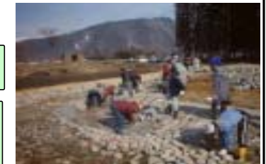
地域住民の参加による施設整備 生態系に配慮した石張り水路の 施工作業
