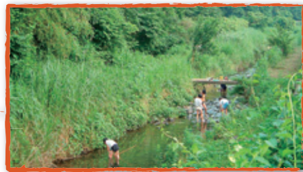
護岸を撤去し、川幅を地形に合わせて変化させた後の様子 撮影：吉村伸一
