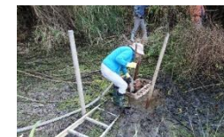
ポンプで水抜き
