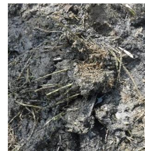
河床部の状況
