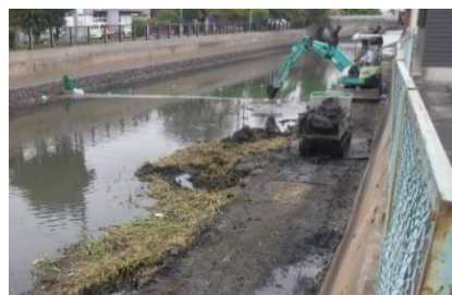
重機による掘取り状況
