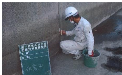
護岸のモルタル補修状況
