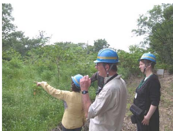
相生山道路建設現場の様子
