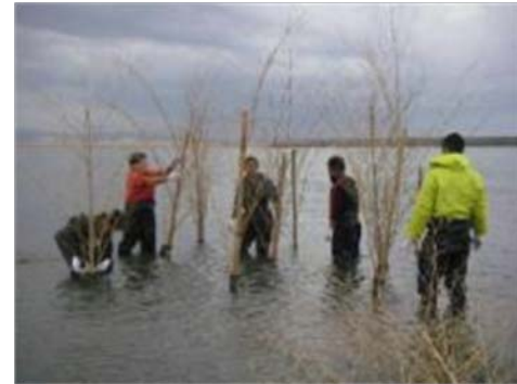
写真10. 逆さ竹林タイプの保護礁設置
