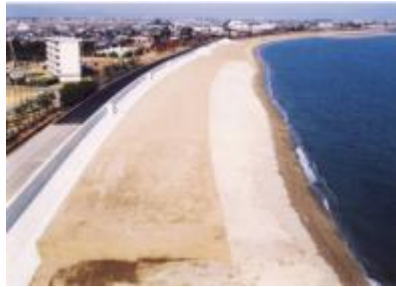
砂浜を再生 (生態系に配慮し近隣の砂を使用)
