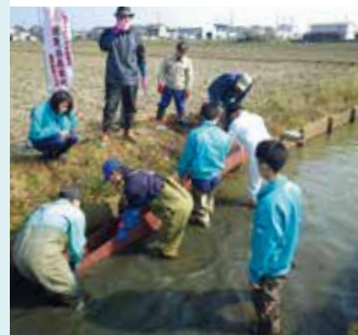
④ 集落総出で魚道を設置
