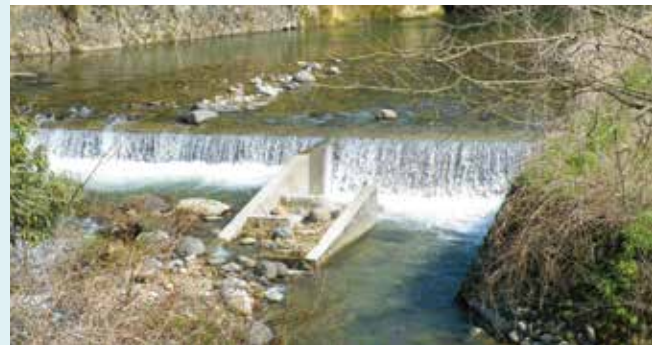
① 過去に設置された魚道が破損
