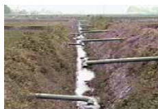
用排分離された水田との連続性が分断された排水路
