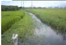
水田と水路が連続している用排水兼用水路
