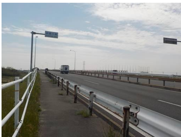
写真 22 鈴鹿大橋の橋梁上
