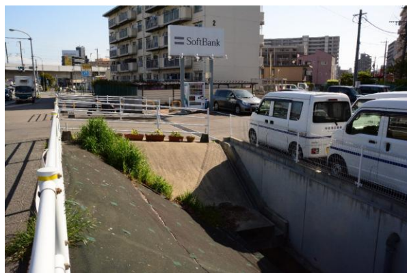
写真 35 須恵川橋の道路沿いの土手を覆う防草シート
