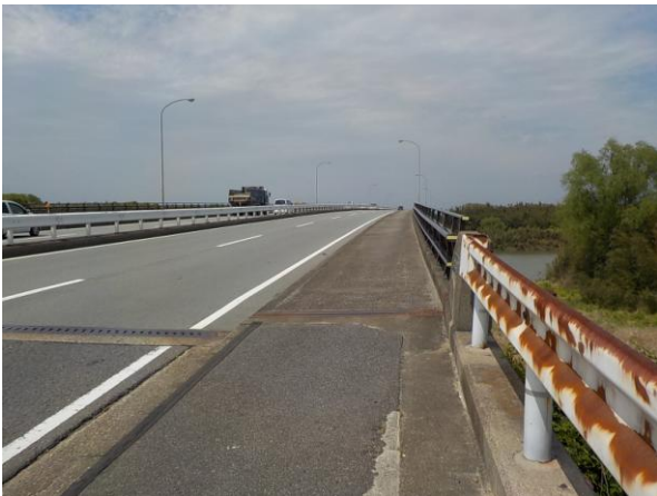
写真 28 雲出大橋の橋梁上
