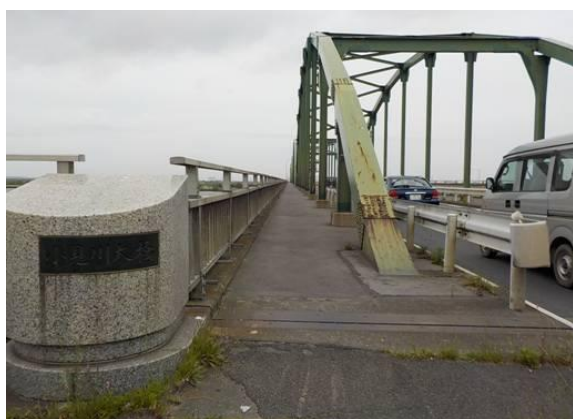
写真7 小見川大橋の橋梁上
