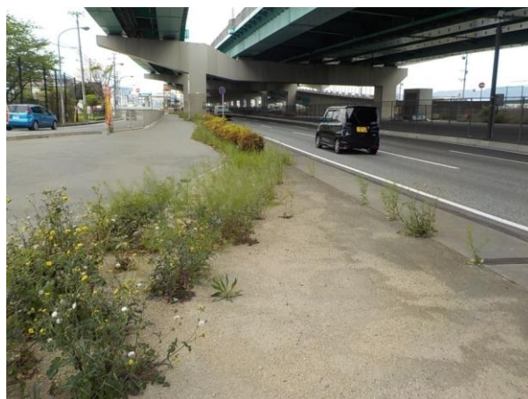
写 40 国道3号線沿いの植栽柵と緩衝帯
