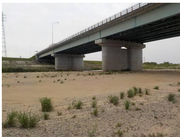
写真 23 鈴鹿川右岸の河川敷の低水路
