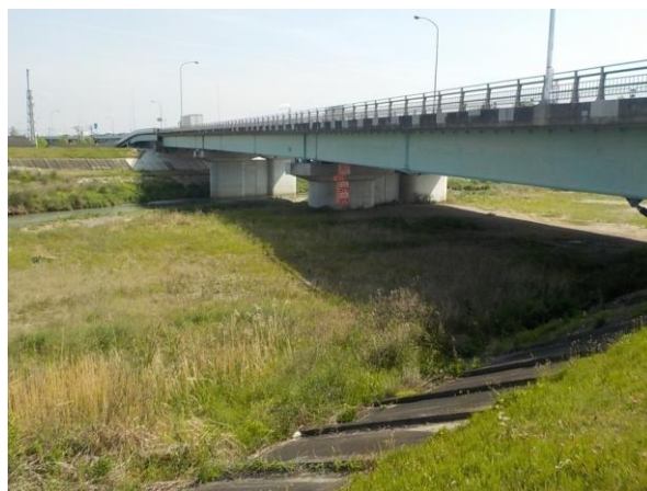
写真 17 内部川右岸の河川敷
